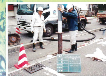
塩ビ管、浸透シート建込み
