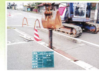
鋼管差し込み
