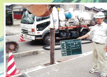
鋼管引き抜き
