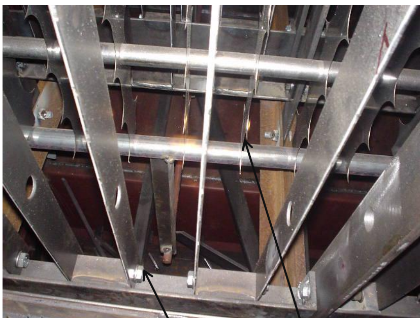
集塵極・放電極目視点検中
